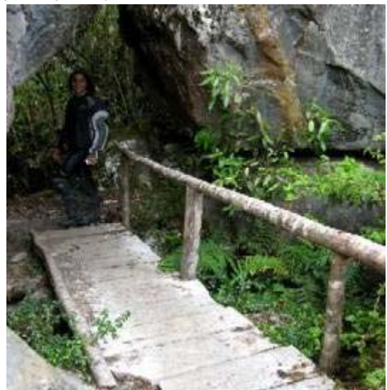
Fig. 4.21: Pequena ponte sobre drenagem (Foto: C.T. Blum).
