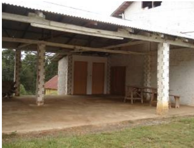
Figura 4.7: Exemplo de barracão existente em uma das áreas adotadas pelo Programa Desmatamento Evitado, com sala de projeção à esquerda e sanitários ao fundo (Foto: L. Akemi)
