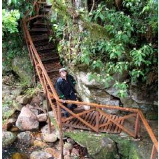
Fig. 4.19: Escada com passarela de madeira para região íngreme junto a rio (Foto: C.T. Blum).
